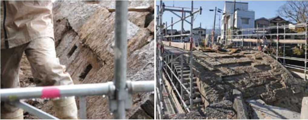
輪石背面の四角形のホゾ穴。ホゾ穴のある石材は桁橋や樋門などに使用されていた石材の転用か =2018年5月6日撮影
