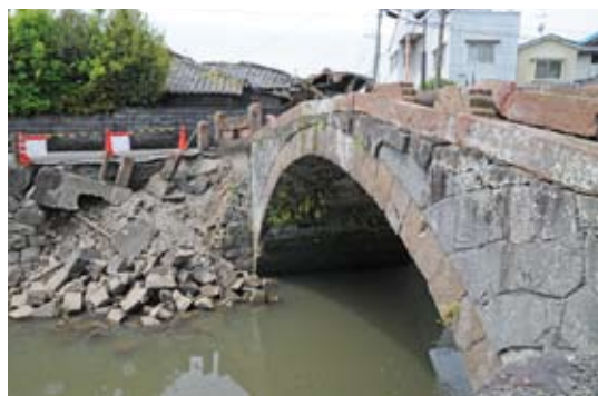
被災後の船場橋の上流側 =2016年5月2日、中村まさあき撮影
