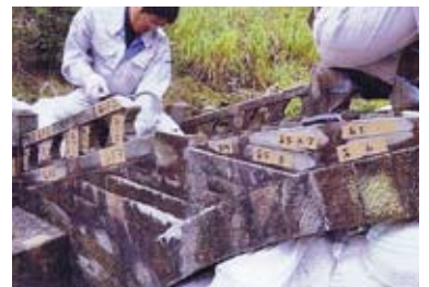
諫早市に移築するための解体の様子
