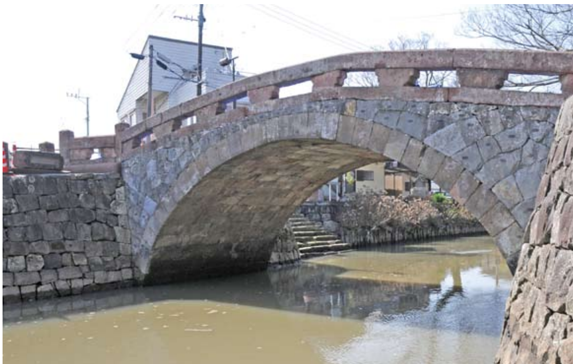
復旧工事がほぼ終了した船場橋。写真は上流側 || 2020年3月2日、中村まさあき撮影
