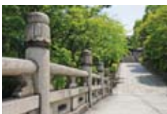
上) 円通橋 (通称・めがね橋)。京都市東山区五条橋東(大谷本廟内)、1856(安政3)年架橋、橋幅約6㍍、橋長約24㍍。真円のトンネルを2つ連ねたアーチが特徴的。石材には花崗岩を使用 左) 高欄には円筒形の手すり石や逆蓮(ぎゃくれん)柱、格狭間(こうざま)などの意匠が施されている
