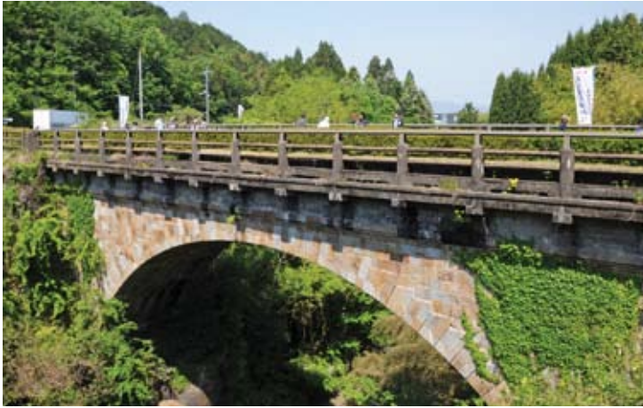
王子橋 (通称・めがね橋)。京都府亀岡市篠町王子、1884(明治17)年架橋、径間約25㍍、橋幅約5.5㍍。橋の設計は琵琶湖疎水の工事主任を務めた田辺朔郎。土木学会推奨土木遺産
