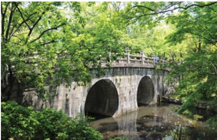
上) 円通橋 (通称・めがね橋)。京都市東山区五条橋東(大谷本廟内)、1856(安政3)年架橋、橋幅約6㍍、橋長約24㍍。真円のトンネルを2つ連ねたアーチが特徴的。石材には花崗岩を使用 左) 高欄には円筒形の手すり石や逆蓮(ぎゃくれん)柱、格狭間(こうざま)などの意匠が施されている
