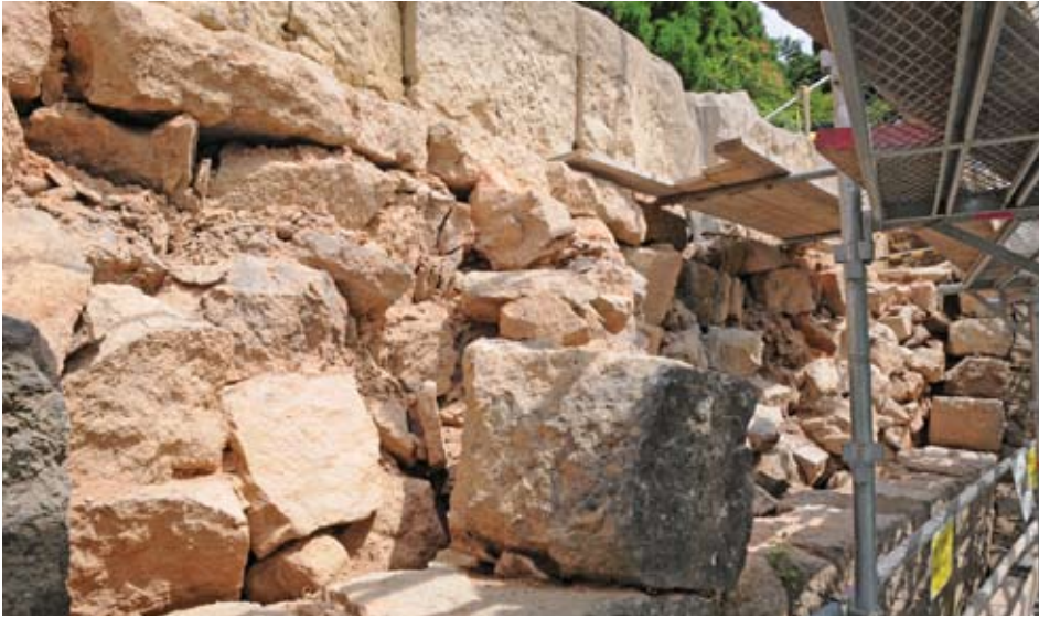
あらわになった通潤橋の裏築(うらつき)。上に並ぶ四角い石が通水石管で、その直下に板状の敷石が並ぶ。裏築には多くの大きな石が使用される中、敷石の下の一部には丸い小さな小石「円礫(えんれき)」も見られる
