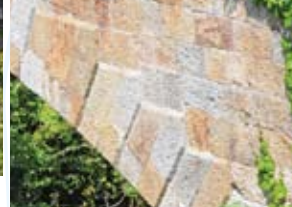
王子橋の輪石と壁石は「夫婦天端(めおとてんば)」と呼ばれる珍しい構造。石材は花崗岩
