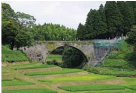
右岸上流側に作業用の足場が設置された通潤橋
