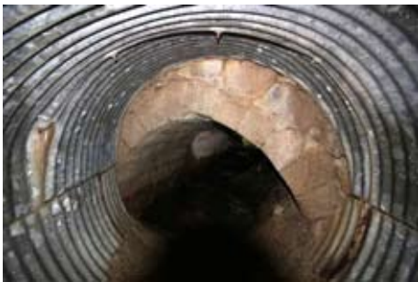
市道地下の暗きよの一部となっている「兎谷川渡橋」 写真提供/賛田岳和
