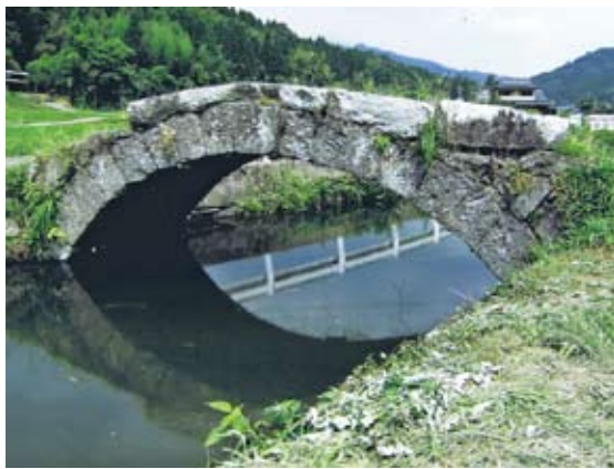
「石貫車橋」熊本県玉名市石貫、橋幅1.9m、径間5.03m 写真提供/田上あけみ
