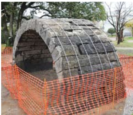
八女公園内に移築された本眼鏡橋。耐震補強のため輪石はステンレスチェーンで締められている =2018年3月16日中村まさあき撮影
