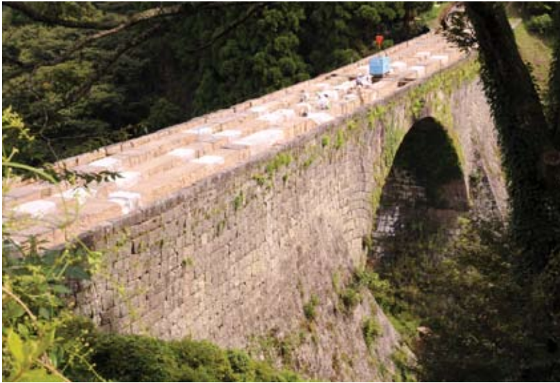
通水管の漆喰の詰め替え作業が行われている通潤橋=2017年9月、山都町
