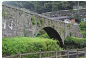
立門橋(菊池市) 《竣工》 左岸下流側(右奥)の取付護岸の崩落した石垣やコンクリート路面を修復
