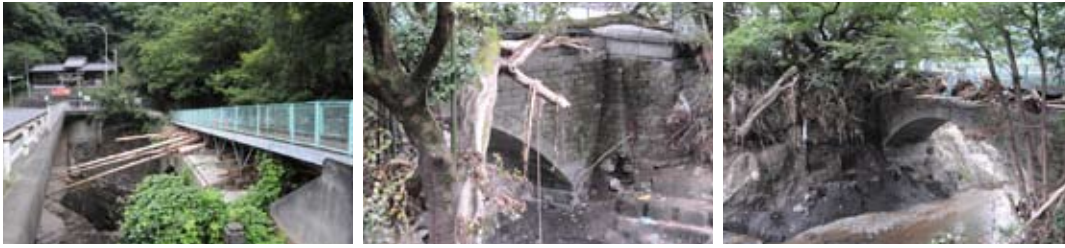
大肥橋。左は流木が引っ掛かった下流側。中は基部部石垣が損壊した上流右岸側。右は路面上にがれきりはさまった上流側
