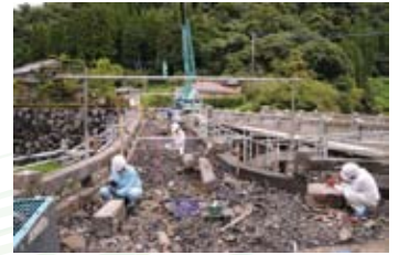
二俣福良渡(美里町) 《施工中》 高欄の修復の様子。輪石の基底のみ残して解体後、失われた壁石や高欄は新材で補い、あらためて組み立てが行われている。10月竣工予定
