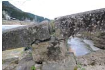
大窪橋(美里町) 《竣工》 損壊し路面側に倒れた高欄を修復。折れた手すり石が接がれている
