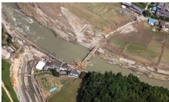
上、豪雨直後の宮ヶ原橋。写真上が右岸=2012年7月 写真提供/大成ジオテック㈱
