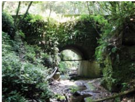
皆倉の石橋 肝属郡錦江町神川 皆倉(かいくら) 橋幅3.0m 径間3.64m 拱矢1.68m 環厚:42cm 輪石17列
