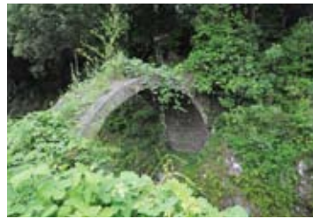
むきだしの輪石のみの姿で流失を免れた筏場目鏡橋
