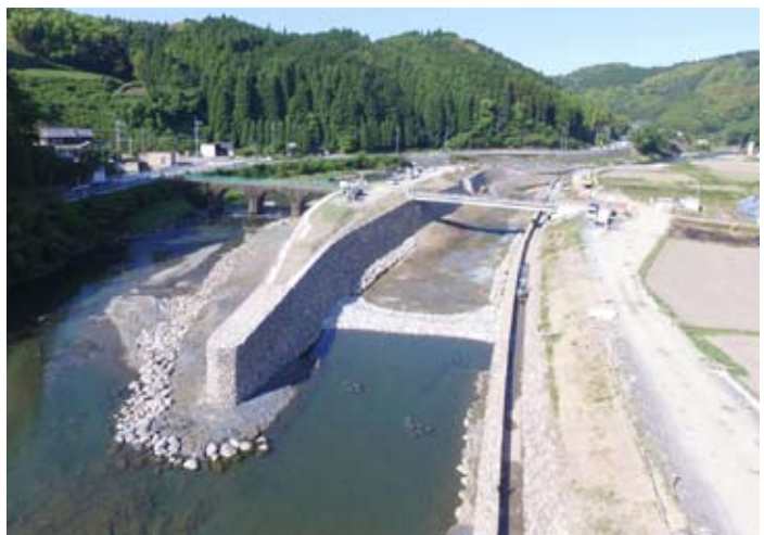
右、右岸に中の島と新橋が完成=2017年6月 写真提供/福岡県八女土木事務所
