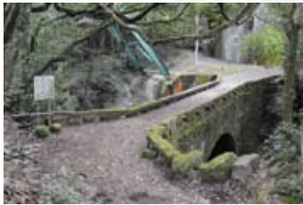
馬門橋(美里町) 《竣工》 地震の揺れで全て路面の内側に倒れた高欄を修復
