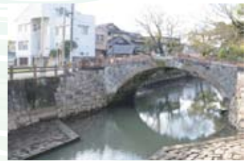
船場橋(宇土市) 左岸上流側の取付護岸横の石垣修復。本体は今後、工事の見込み
