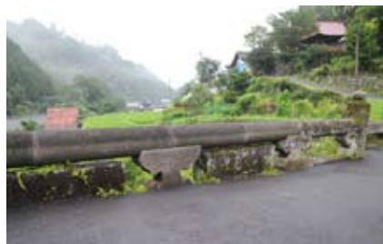
永山橋(菊池市) 《竣工》 川に落下し、流失した高欄の復元。1本が長さ3mほどあった円筒形の手すり石は、その半分の長さの新しい石材を使い、中に金属棒を入れてつぎ目を接着剤で接合されている。アスファルトの路面も修復
