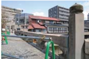
明八橋(熊本市中央区) 《竣工》 路面側に倒れた上流側の高欄(1990年修復)を修復
