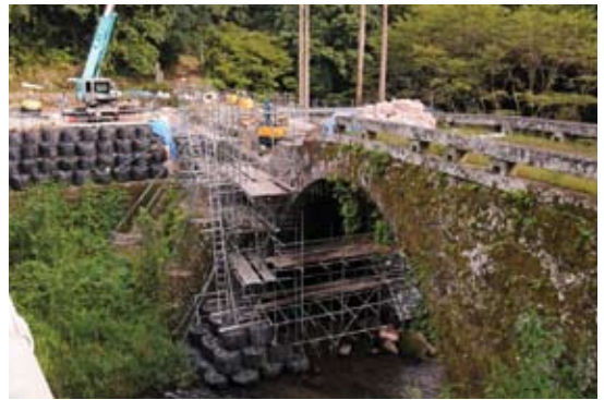
八勢目鑑橋(御船町) 《施工中》 地震で崩落した石材を回収し、40%ほど上流側にずれ動いた左岸石垣を袖石垣上部の位置まで解体し、再度、組み立てる。回収した石材は、被災前の写真と照合し、位置を特定した上で旧材が使用されている
