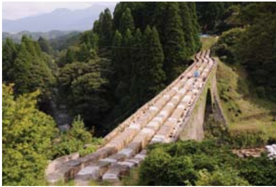
通潤橋(山都町) 《施工中》 橋上の土を除去し、外側に迫り出した右岸の鞆石垣上部の壁石については、上部3段を解体して積み直しが終了。その後は、石造通水管の接合部に充填されている漆喰の詰め替え作業が行われている
