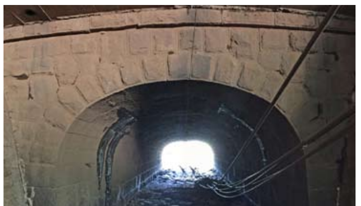
呑口よりアーチ内部。石材表面に土石流の泥が付着し、一部に水がしみ出ている(2016年11月中村秀樹撮影)
