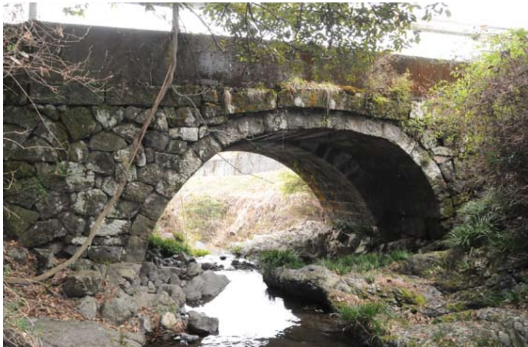
1817(文化14)年架橋の古殿橋 大分県豊後大野市大野町北園、径間5.6m、橋幅1.8m、市指定有形文化財 アーチの奥には1920年に同じ径間で拡幅された古殿2号橋の輪石が見える 写真提供/中村まさあき
