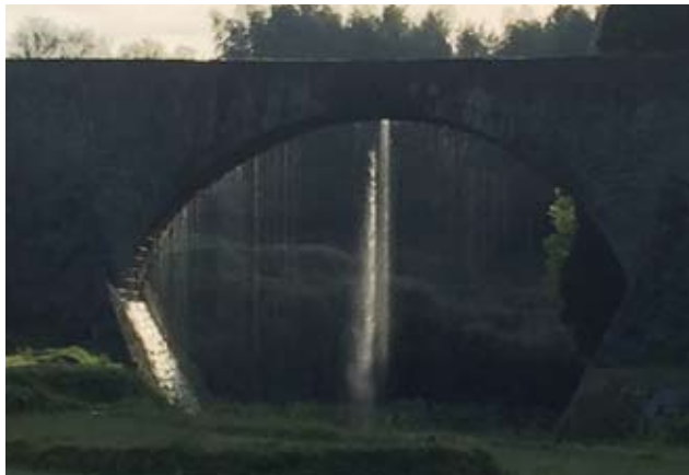
本震後に漏水が発生した通潤橋（昨年4月16日、写真提供/尾上一哉）
