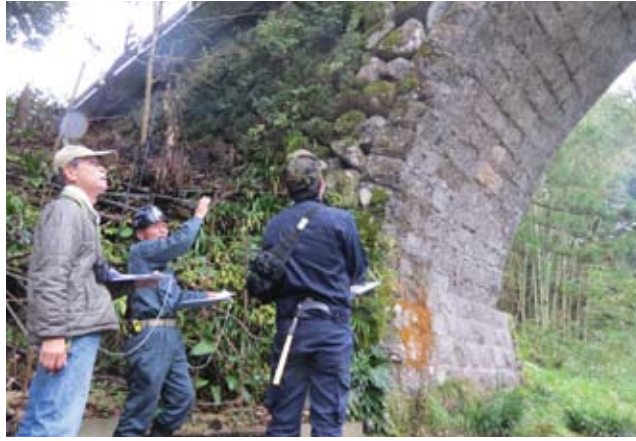
石橋定期点検の様子(2015年11月、写真提供/同会)
