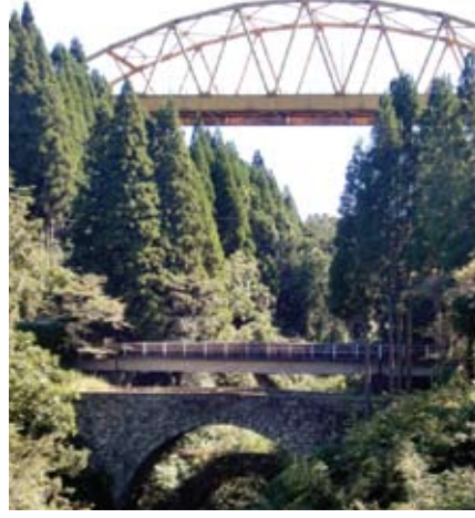
写真1 岩戸橋(大分県竹田市)
