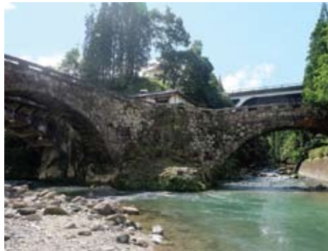
写真2 二俣五橋(熊本県美里町)全景 左手前が二俣福良渡、奥が新二俣橋、 右手前が小筵二俣、奥が新年杵橋と年杵橋
