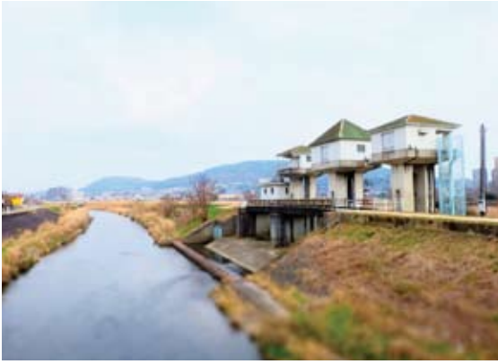
写真1 坪井川遊水地の水門(熊本市北区) 川の増水時に遊水地に水が入り、減水後に徐々に水が戻る構造
