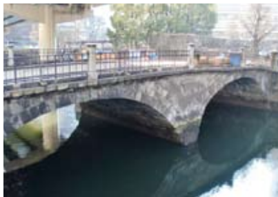
写真3 常磐橋(東京都千代田区) 日本橋川に架る明治初期に築造された石橋。東日本大震災で被災し、現在は復旧工事中
