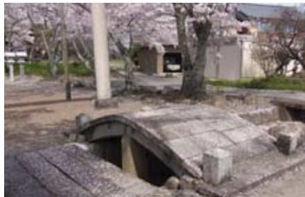
④ 和野八幡神社太鼓橋 甲賀市水口町和野、1703(元禄16)年架橋
