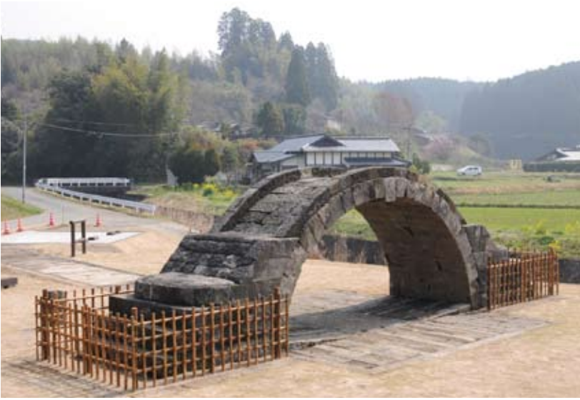
保存工事が完成した平山橋(2015年3月22日撮影)
