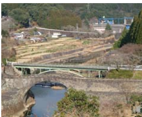
写真4 霊台橋(美里町) 上流(右上)の緑川ダムで霊台橋は守られている
