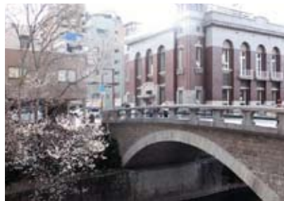
写真2 明十橋(熊本市中央区) 扁平アーチで路面は平坦、幅も広く県道橋として現役。名工、橋本勘五郎の傑作
