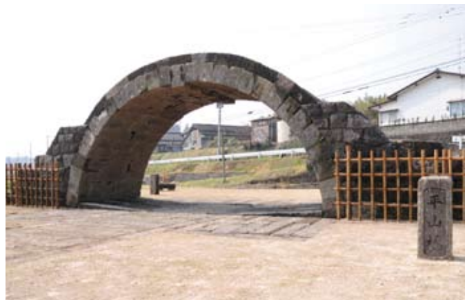
1861(文久元)年築造部分のみを保存
