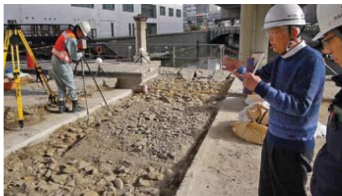
常磐橋の路面敷石の下にはコンクリートの層が出現。関東大震災時の修復と見られる。奥に見えるアーチ橋は昭和10年に架設された鉄筋コンクリート工法の「常盤橋」=今年2月撮影(*a)
