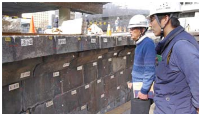
常磐橋の壁石の各石材には番号が振られ、復旧工事の際、上下左右の石材の接合位置が分かるよう朱の墨が引かれている。上塚尚孝事務局長(左)に説明をする文化財保存計画協会の西村祐人氏(右)=今年2月撮影(*a)
