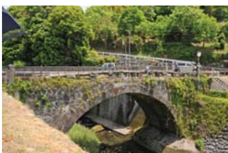
高井川橋=鹿北町(*c)
