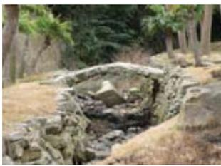
石橋は2009年に建造、径間約3尺、橋幅約2.5尺、拱矢0.2尺。
