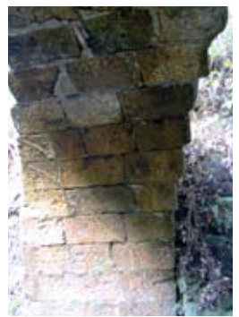
アーチを下から見た桂ヶ谷水路橋
