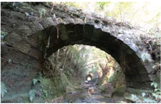
斜めに架かる桂ヶ谷水路橋
