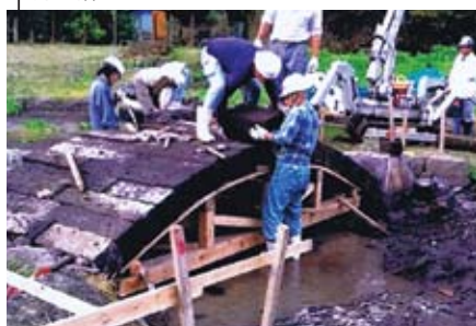
▲12/10閉講式後の記念撮影 支保工に据えたジャッキを下げると、輪石が 連結。支保工を撤去し、縁石、親柱などを取 り付け、実習橋が完成。写真は竹部師匠(手 前中央)と受講者6人
