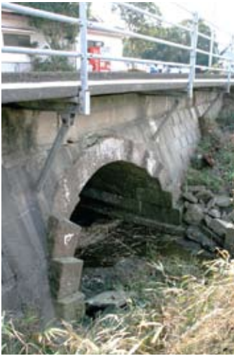
基部の輪石が順に突き出し台形をした高松橋
