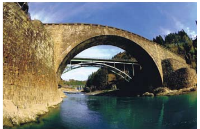
霊台橋(熊本県上益城郡美里町) 写真提供/上塚 尚孝
