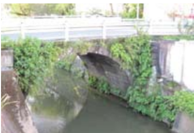
平山橋 1861(文久元)年架設、1914(大正3)年改修、橋長11.3m・径間7.0m・橋幅4.8m 写真提供/河村 修
