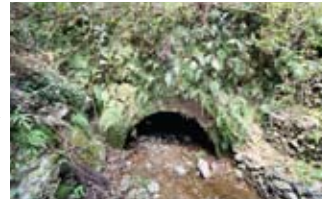
三号坂橋(仮称) 宮崎県都城市高城町四谷 径間1.8m、拱矢0.9m 環厚43cm、輪石9列 写真提供/費田 岳和
