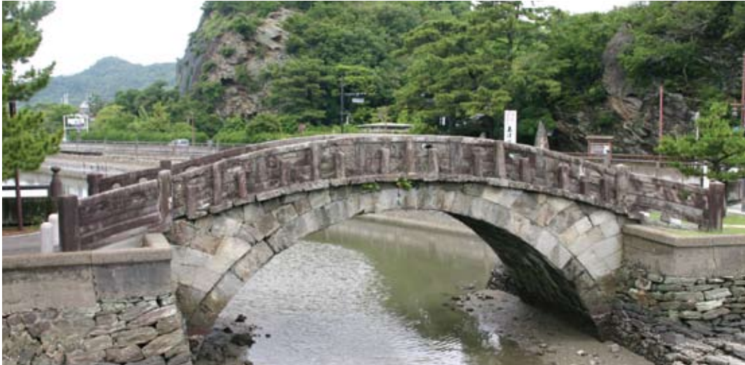
不老橋(和歌山県指定文化財) 和歌山市和歌浦、1851(嘉永4)年架橋、橋長14.7m、径間9.6m、橋幅4.2m 写真提供/加藤 元昭
