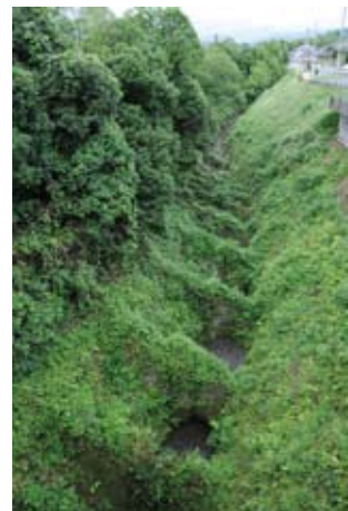
▲菊陽町の「鼻ぐり井手」。用水路途中の岩盤(長さ約390cm)を掘削し、3〜4日間隔に水流穴(鼻ぐり穴)を空けた隔壁を設けている。隔壁にぶつかった水流が、火山灰などの土砂を巻き上げて流すため、しゅんせつ作業がいらぬ。写真提供/中村まさあき
