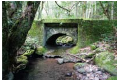
西目林道第1号橋 熊本県人吉市木地屋町(橋谷川) 橋幅3.75m、径間3.4m 拱矢1.6m、環厚33cm 輪石13列 写真提供/費田 岳和
