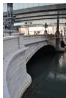
補修後の日本橋 写真提供/伊東 孝
