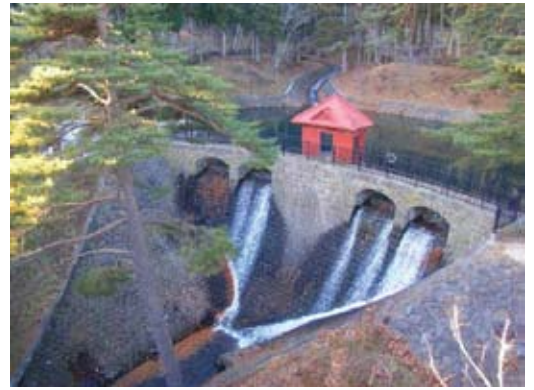
大湊第一水源地堰堤 写真提供/吉田 晃
