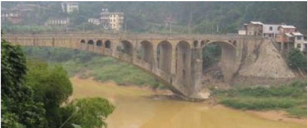
金山大橋(中国・福建省) 架設1972年、橋長150m、径間99m
