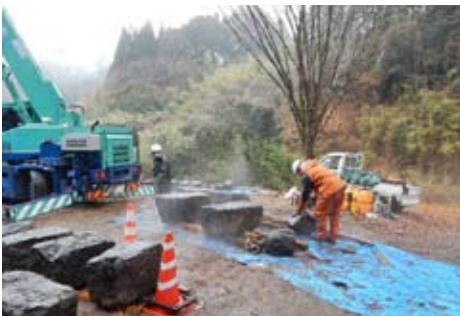
仮組み前の輪石を高圧洗浄機で洗浄
