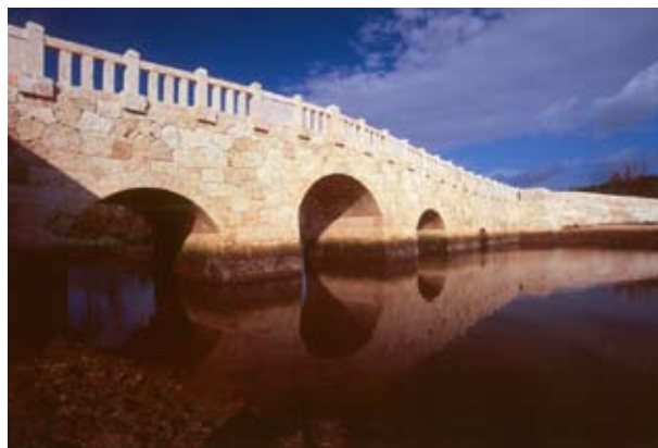
沖縄県宮古島のマングローブ公園内に架かる「島尻入江橋」
