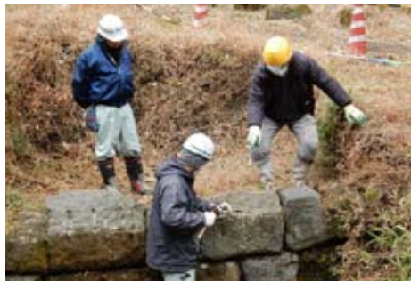
伝統工法で基礎石の加工を行う
