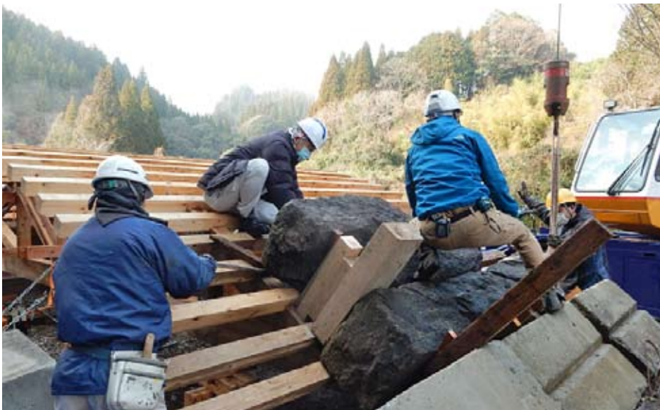
シン北川内橋架設実習で、支保工の上に輪石を置いて並べる仮組みを行う受講者
