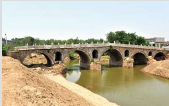
中国の代表的な空腹式アーチ橋「単橋」 写真提供/榊 晃弘 =河北省滄州市、明代の1629年架設、全長77.5m
