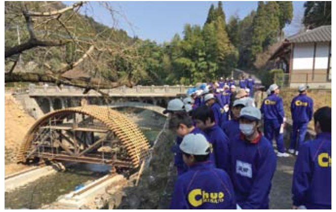
熊本地震の震災復旧工事が完了した二俣福良渡目鑑橋を訪れた地元中学生を案内(2017年) 写真提供/石造文化財技術機構
