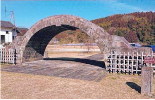
2015年に平山温泉内に公園を整備して移設保存された平山橋 写真提供/上妻信寛
