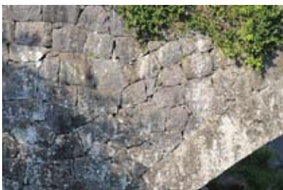
下鶴橋(熊本・御船町、町指定有形文化財) 上/高欄の円筒形の手すり石の部分に被害はない。中/高欄の厚いかまぼこ型の手すり石が損壊。下/壁石は石材同士がぶつかり合っ てひびが入った箇所がある(5.2)
