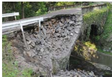
下梅木橋(熊本・御船町) 壁石が崩落して中込め石が川に散乱(5.2)
