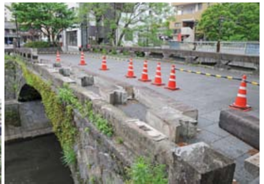
明八橋(熊本・熊本市) 左/築造に高度な技術を要する扁平なアーチ。上/倒れた高欄(4.23)
