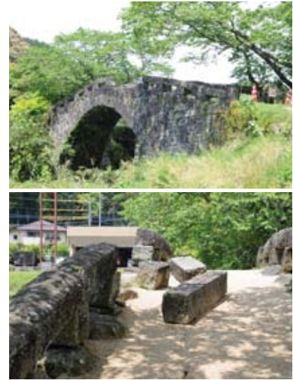
大窪橋(熊本・美里町、町市定有形文化財) 路面の方に倒れた手すり石(5.2)
