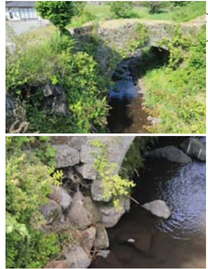
境川古橋(大分・竹田市) 上/右岸側の護岸石垣が崩落している、下/輪石の基礎部付近が損壊(6.3)
