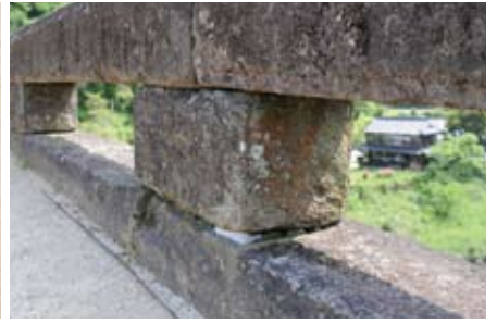
霊台橋(熊本・美里町、国指定重要文化財) 左/高欄の手すり石のずれ。右/手すり石の安定を保つためか、束柱の下に鉛の板が挟まれている(5.2)
