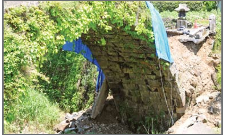
安見下鶴橋(熊本・宇城市、市指定有形文化財) 左上ノ地震により壁石が崩落(5.12)。右上ノ記録的な大雨により、もろくなった橋は6月21日に流失(6.25)。下ノ輪石が開き、石材の欠落もあった(5.12)
