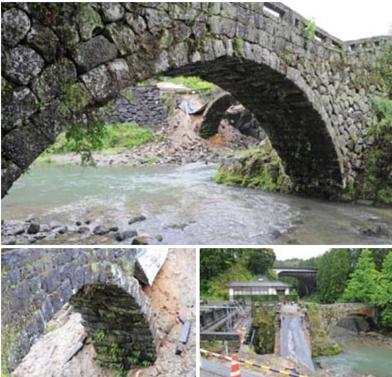
二俣福良渡(熊本・美里町、町指定有形文化財) 上/大きな石の間に小さな石を入れて構造を支える「打込接(うちこみはぎ)」工法の名残がある壁石。左下/右岸側の壁石が崩落し輪石がむき出しになった状態で耐えている。右下/津留川(手前)と釈迦院川(右側)の合流地点にL字型に架かる(4.27)
