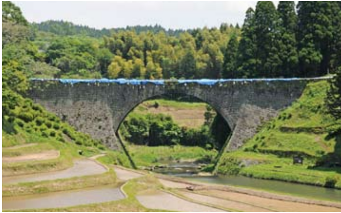
通潤橋(熊本・山都町、国指定重要文化財) 漏水のため通水が止まり、路面がブルーシートに覆われた
