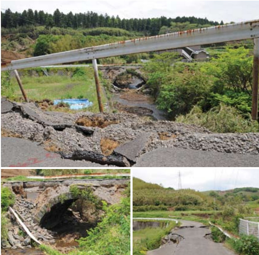
銭瓶橋(熊本・南阿蘇村) 上/U字カーブを描く旧道の道路も路肩が崩れ、路面のアスファルトが損壊。左下/壁石が崩落し輪石がむき出しになり、ガードレールも損壊。右下/路面は通行禁止。正面奥の送電線の鉄塔も傾いている(5.15)
