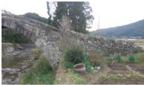
施工前の左岸下流側
