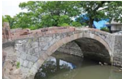
船場橋(熊本・宇土市、市指定有形文化財) 高欄損壊のほか、輪石に亀裂、壁石にはらみが見られる(5.2)
