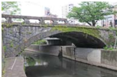
明八橋(熊本・熊本市) 左/築造に高度な技術を要する扁平なアーチ。上/倒れた高欄(4.23)
