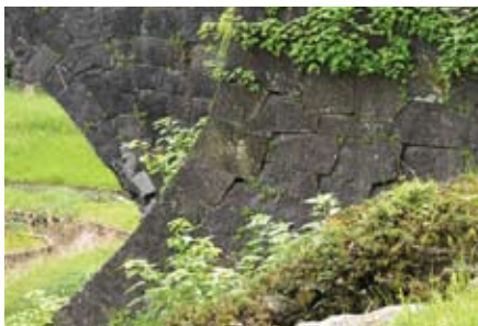
大坪橋(熊本・山鹿市) 輪石に亀裂や欠落、壁石にはらみが見られる(7.21)
