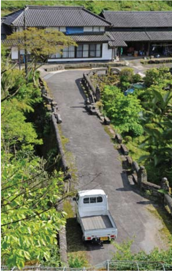
永山橋(熊本・菊池市、県指定重要文化財) 高欄が損壊し一部が川へ落下。アスファルト舗装された路面には亀裂がある(4.29)
