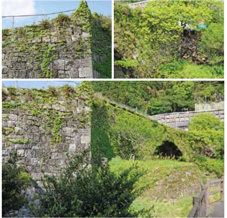
立門橋(熊本・菊池市、県指定重要文化財) 左上/石垣のはらみ。右上/取付護岸石垣の崩落。下/被害のあった右岸下流側の様子(4.29)
