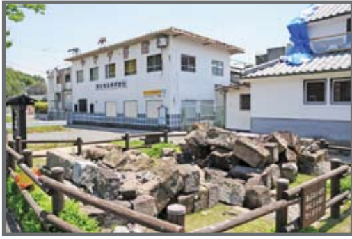
須ノ前橋(熊本・宇城市) 2013年に輪石のみ復元されたが崩壊(5.13)
