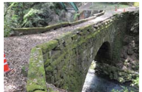
馬門橋(熊本・美里町、町指定有形文化財) 路面側に倒壊した手すり石。震災前から左岸側の壁石にはらみが見られる(5.2)
