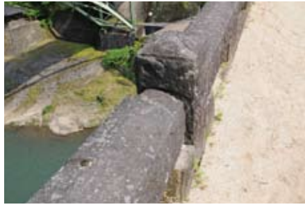
霊台橋(熊本・美里町、国指定重要文化財) 左/高欄の手すり石のずれ。右/手すり石の安定を保つためか、束柱の下に鉛の板が挟まれている(5.2)
