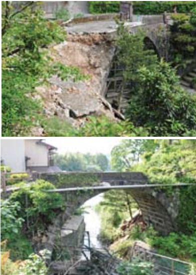
須ノ前橋(熊本・宇城市) 2013年に輪石のみ復元されたが崩壊(5.13)
