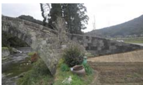
施工後の左岸下流側
