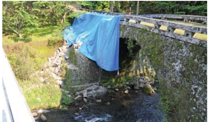
八勢目鑑橋(熊本・御船町、県指定重要文化財) 左岸上流側の取付石垣が崩落。輪石の亀裂や壁石のはらみが見つかった(5.2)
