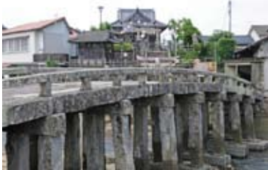
祇園橋(熊本・天草市、国指定重要文化財) 上/路面の石柱に入った長い亀裂(7.18)
