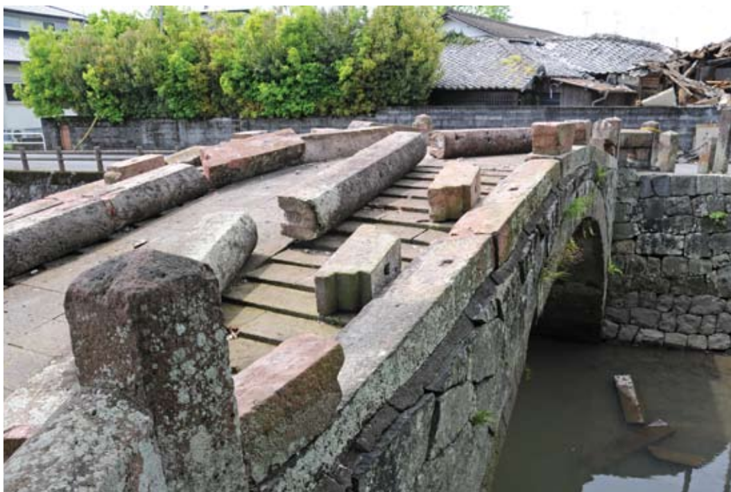
被災した熊本・宇土市の「船場橋」(1861年架橋、市指定有形文化財) 写真提供/中村まさあき
