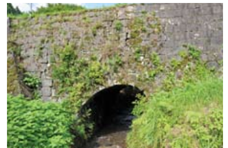
立野橋(熊本・山都町、町指定有形文化財) 地震で壁石のはらみと開きが拡大した(7.17)
