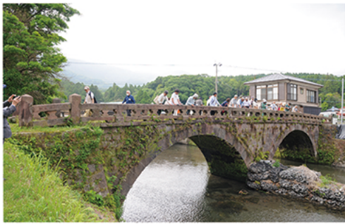
1904(明治37)年架設の「大園橋」(市指定文化財) 写真提供/中村まさあき
