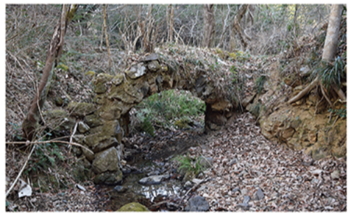
上は、苅生の石橋の側面。 左は、コンクリートで補強された輪石
